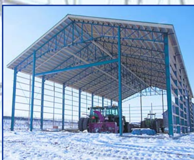
M. PERRON ST-JACQUES ENTREPÔT À MACHINERIES
